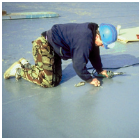
Fig.2: Control de las soldaduras
